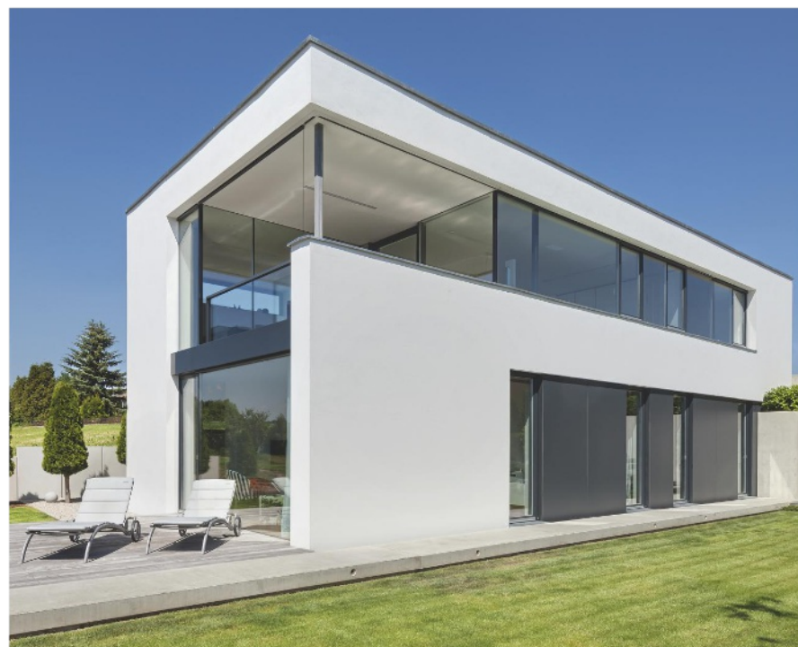
Luftig: Offenporiger Leichtbeton konnte wegen geringer Druckfestigkeit bisher kaum konstruktiv eingesetzt werden. Neue Perspektiven bei entsprechender Wandstärke bietet jetzt hochwärmedämmender und robuster Technolith mit hohem Luftporenanteil, wie beim Haus Rothmund in Trun.
