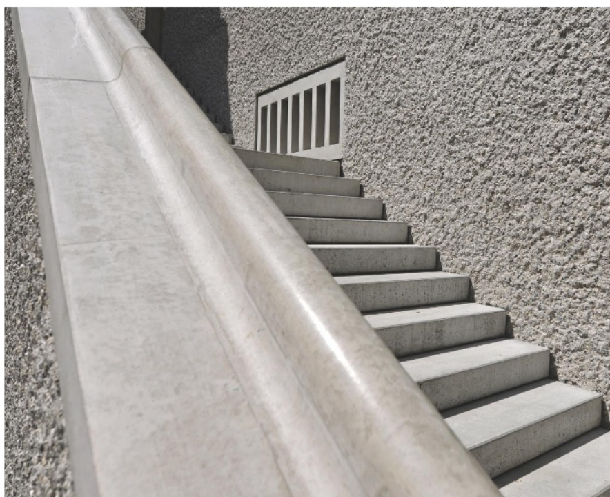
Filigran: Beim Museum für Architekturzeichnung in Berlin machten Sergei Tchoban und Sergey Kuznetsov die Fassaden selbst zu Kunstwerken. Die reliefartigen Oberflächen entstanden durch ornamentale Silikonmatrizen in Transportbeton der anspruchsvollen Sichtbetonklasse SB4.
