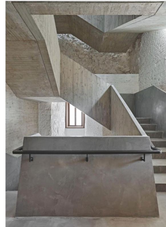
Leichtgewicht: Beim Umbau des Schlosses in Wittenberg ergänzten Bruno Fioretti Marquez ein Treppenhaus und Räume für das Predigerseminar auf dem Dach. Der Liapor-Leichtbeton belastet die Statik des Bestands kaum und ist viel leichter als Mauerwerk oder Normalbeton.
