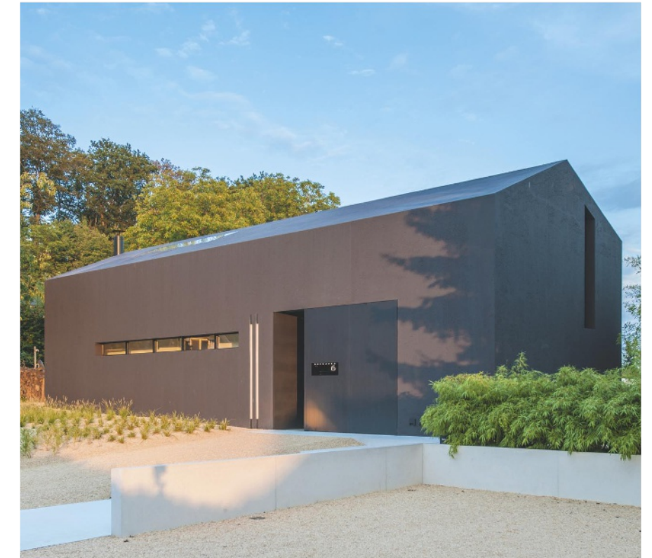
Homogene Haut: Mit dem Haus in Bammental erprobte Thomas Schweigert (siehe Interview) 30 cm starken Leichtbeton vom Typ LC 12/13 D 1.1. Alle Sichtbetonflächen wurden besonders glatt und fugenlos ausgeführt, dann lasiert. Der Entwurf stammt von Architekt Thomas Fabrinsky.
