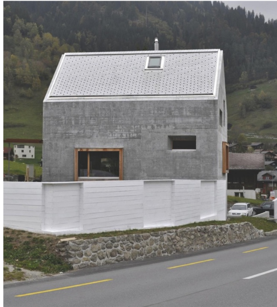
Luftig: Offenporiger Leichtbeton konnte wegen geringer Druckfestigkeit bisher kaum konstruktiv eingesetzt werden. Neue Perspektiven bei entsprechender Wandstärke bietet jetzt hochwärmedämmender und robuster Technolith mit hohem Luftporenanteil, wie beim Haus Rothmund in Trun.
